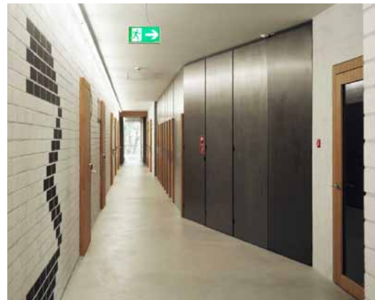
Zentraler Korridor, der Alt- und Neubau verbindet. Hinter den raumhohen Stahlverkleidungen befinden sich die Waschräume. Foto Ruedi Walti
