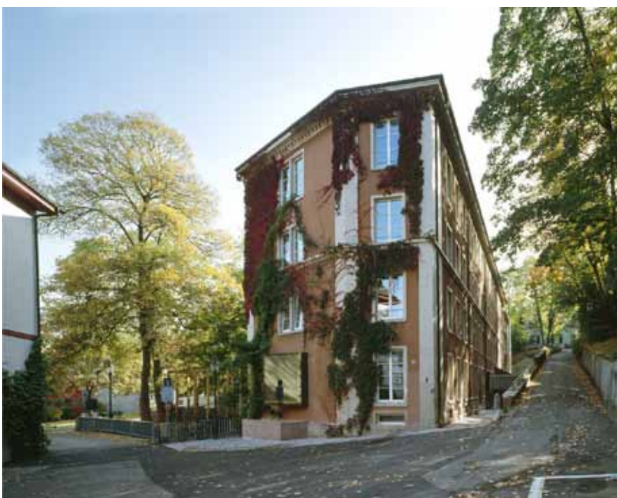
Die Basler Jugendherberge im St. Alban-Quartier am Rande der Basler Altstadt. Ansicht der Westfassade der alten Seidenbandfabrik mit der großen, neu gestalteten, quadratischen Fensteröffnung. Foto Ruedi Walti
