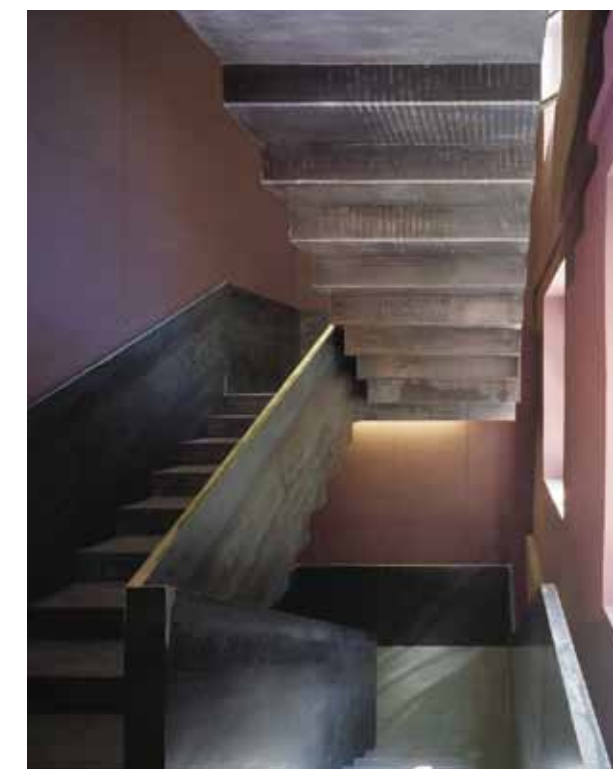
Treppenhaus, einfache und rohe Materialität. Foto Ruedi Walti
